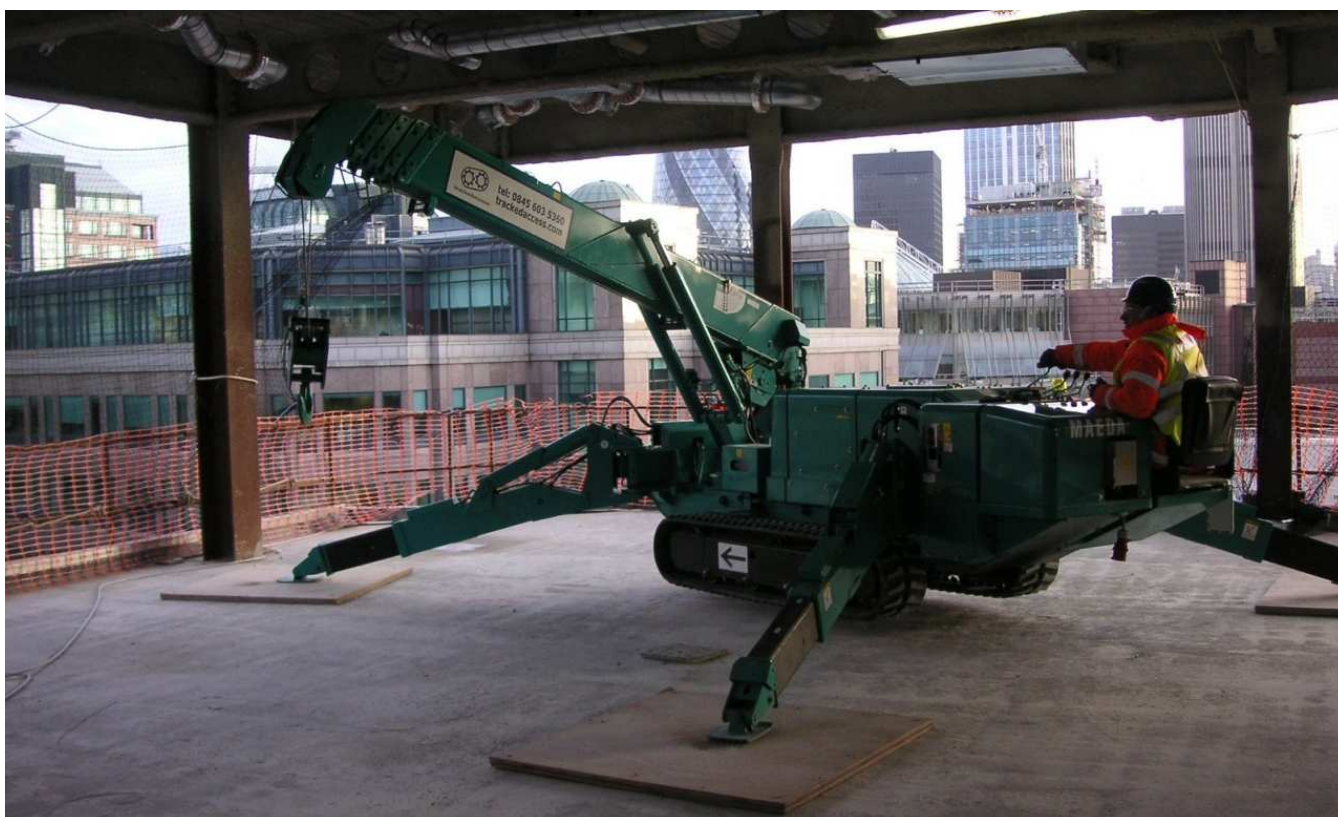
MAEDA MC305CRM-E-2 při práci v patře budoucí kancelářské budovy
